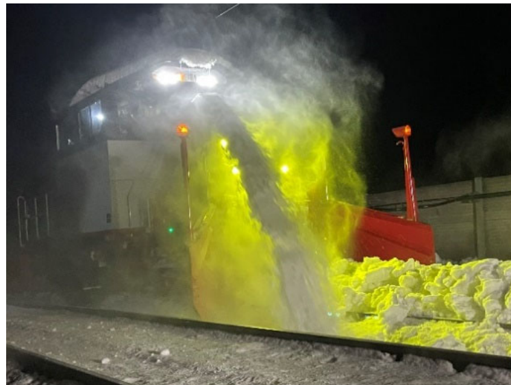
写真 6-8 開口部下側防音壁への投雪試験状況
