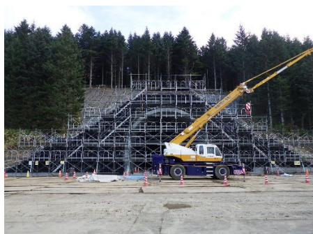
写真 5-3 昆布トンネル
