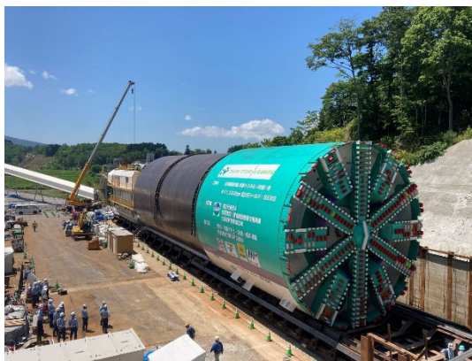
写真 6-6 シールドマシン (羊蹄トンネル (有島) 工区)
