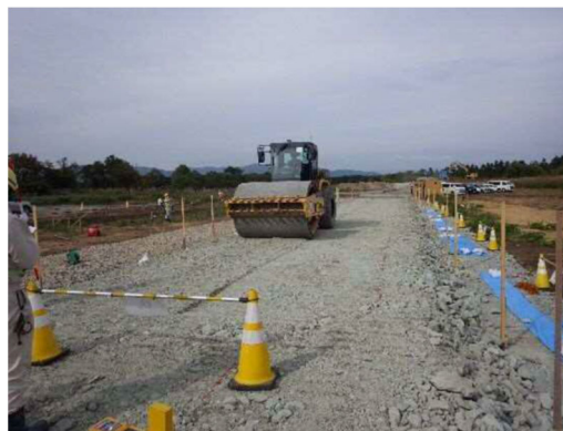
写真 6-5 試験盛土の転圧
