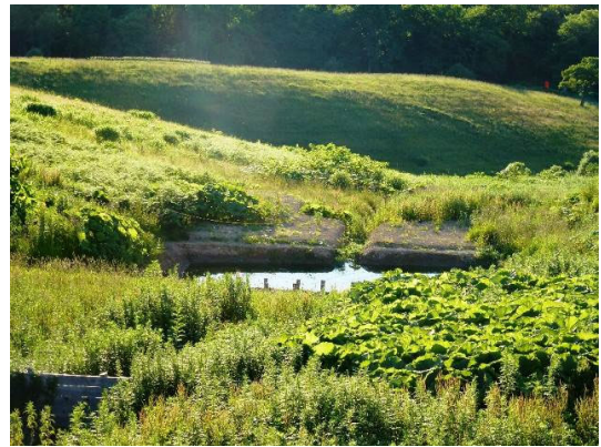
写真 6-15 設置後の様子
