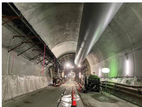
写真 5-1 渡島トンネル
