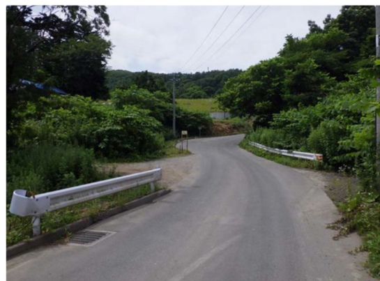
写真 6-11 工事用道路の様子
