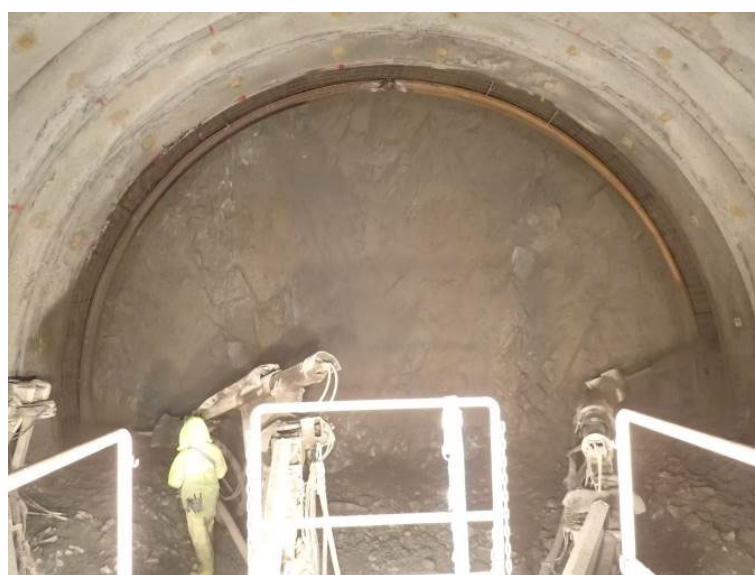
写真 6-9 吹付コンクリート施工の様子
