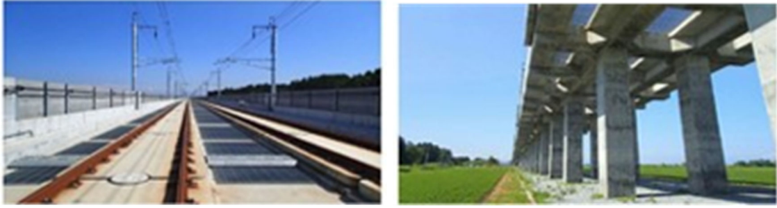
写真 3-6 開床式高架橋
