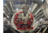
組立て中のシールドマシン
