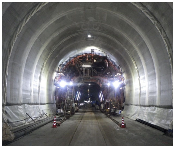
写真 6-3 磐石トンネル
