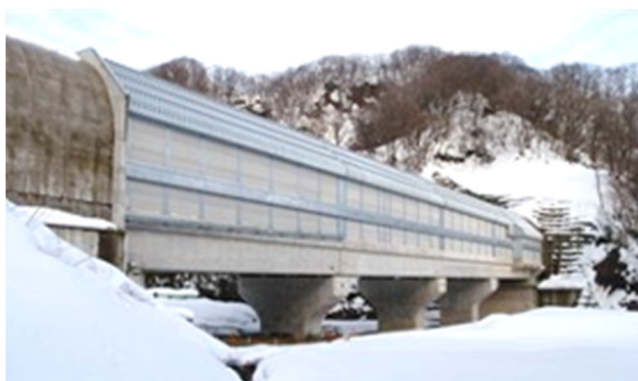
写真 3-4 スノーシェルター
