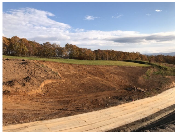
写真 6-10 土地造成の様子
