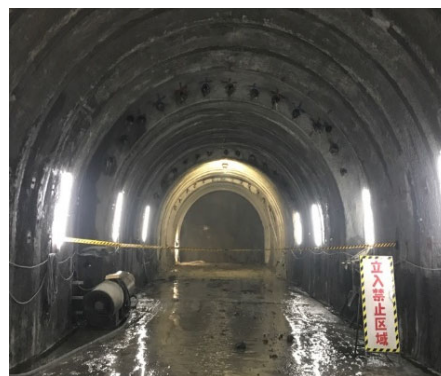
写真 6-7 小断面トンネル施工状況
